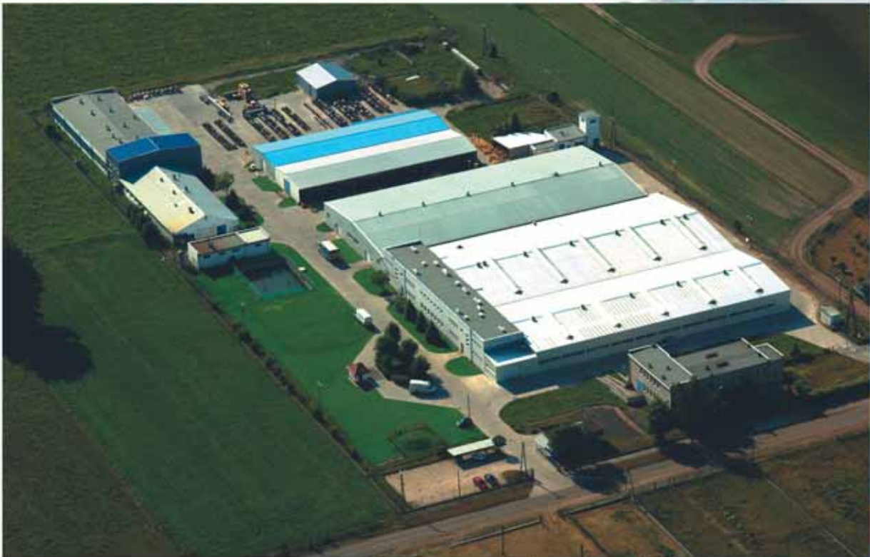
Fabryka kabli Technokabel w Szreńsku k.Mławy
